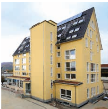
links: Kornspeicher vor der Sanierung im Jahr 2008.
